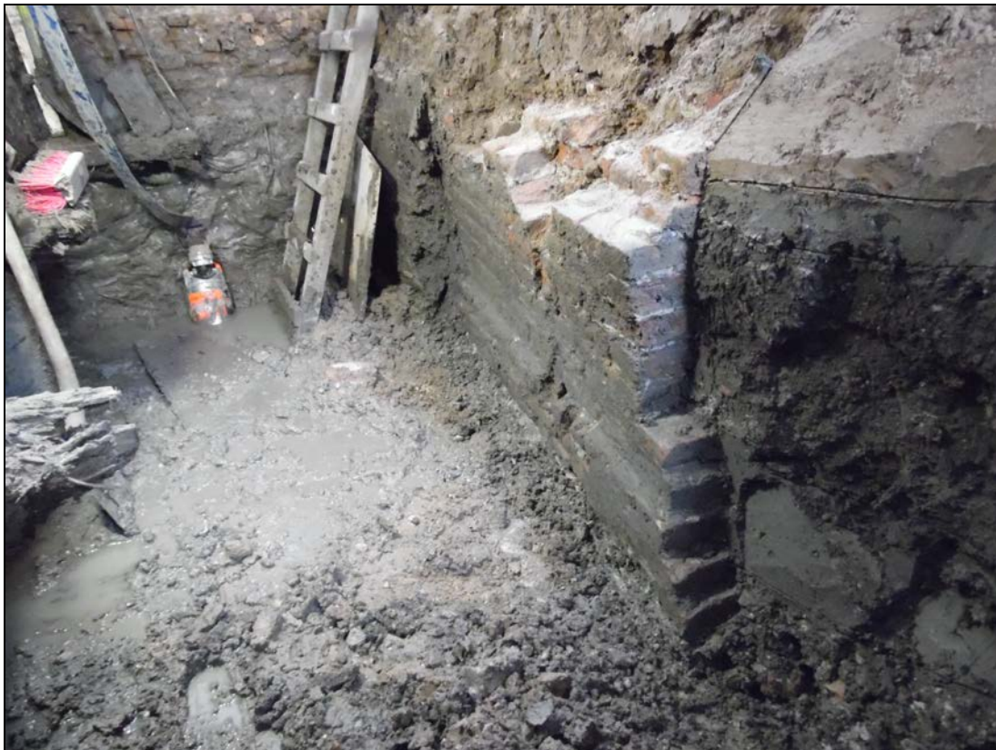
Afbeelding 24. Muurwerk, Spoor nr. 12. Op de foto is een segment van een fundering zichtbaar dat werd aangetroffen in de westelijke werkput binnenin de kerk.
